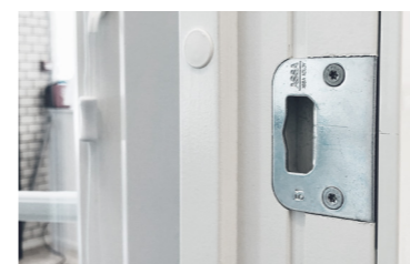
Infällda slutbleck som standard på fönsterdörrar
