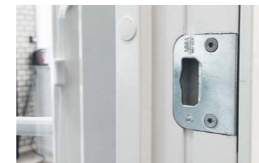
Infällda slutbleck som standard på fönsterdörrar
