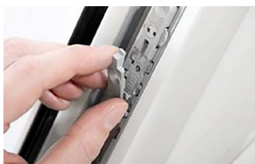
Öppningsspärr i vädringsläge
