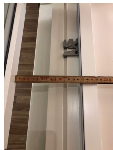
Fig 37. Utfallsäkringen skall låsa bågen så att fritt mått inte överstiger 10 cm.
