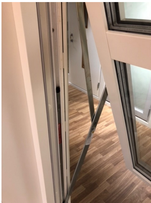
Fig 38. Barnsäkerhetsspärren skall vara monterad på fönster som faller inom kravet på barnsäkerhet i BBR.
