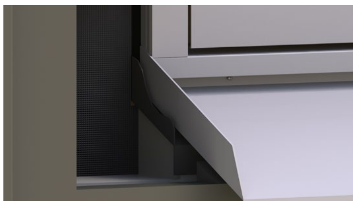
Fig 10. Dränering och luftning skall finnas mellan sekundärtätning och fönsterbleck.
