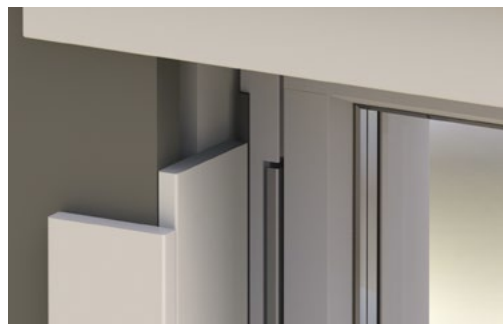
Fig 7. Flexibelt tätband mellan fönstret och fasaden (yttre väderskyddet).
