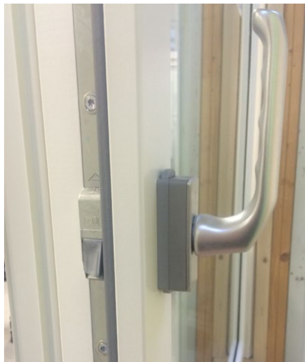
Fig 35a. Felbetjäningsspärr på Kiph dreh-beslag
