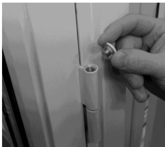
Fig 33. Demonterat täcklock på ställbart gångjärn.
