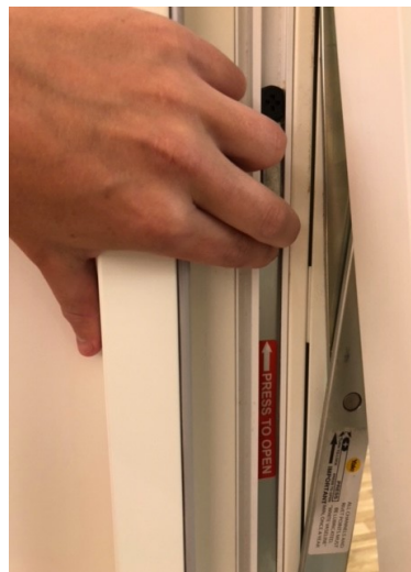
Fig 36. Spärren på beslaget förs mot rummet för öppnande av fönstret.
